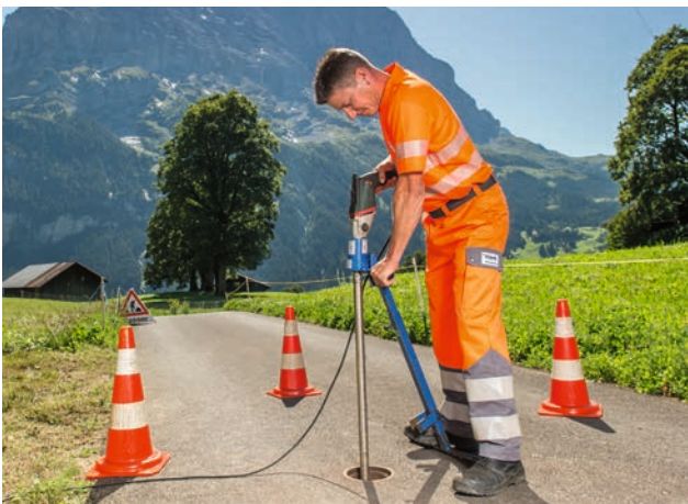
Azionamento prolungato delle saracinesche grippate ANr. 4517
